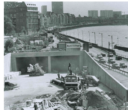
Über der Tunnelleinfahrt im Norden wurden die Tage heruntergezählt.
