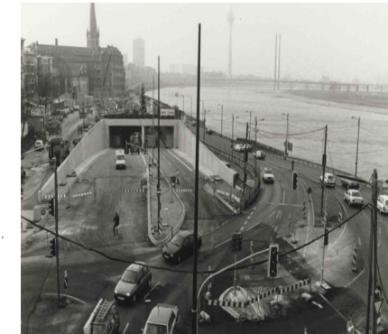
Der Verkehr wurde während der Bauzeit über das untere Werft geführt. FOTOS (5): STADTARCHIV
