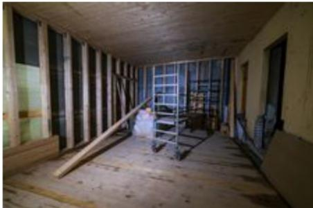
Der Anbau wird auf einem Betonfundament und einem Betonkern im Bereich des Innenhofs in Holzbauweise gebaut. Zukünftig wird dann im Anbau der Rundgang durch die Ausstellung starten, ©Landeshauptstadt Düsseldorf/Michael Gstettenbauer
