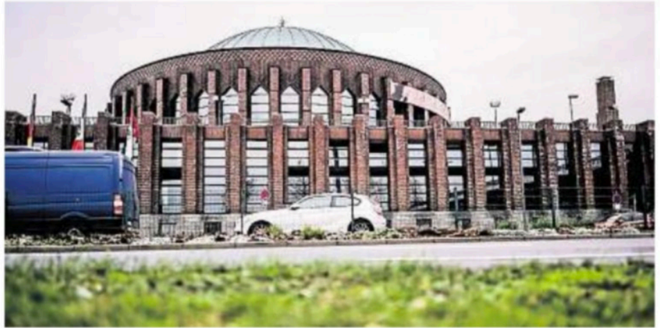
Die Fassade der Tonhalle soll rundum saniert werden.
