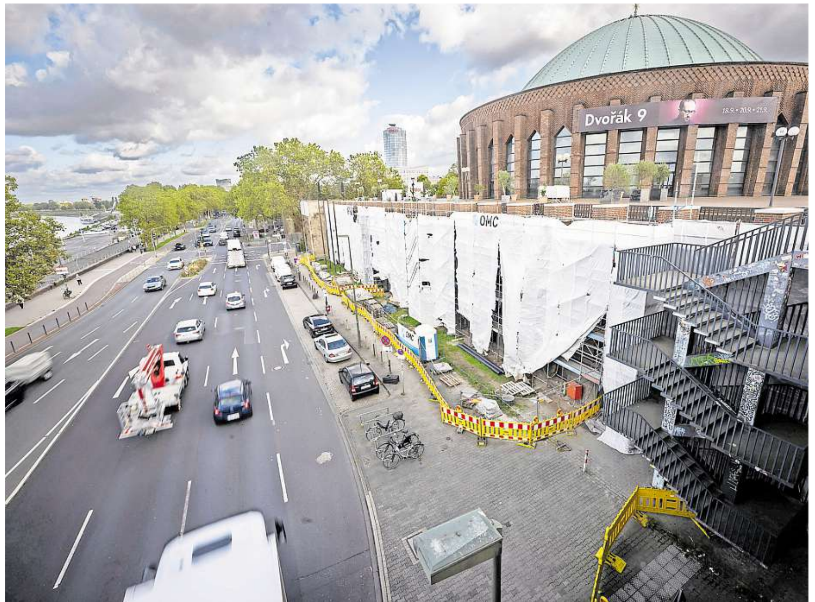
Noch läuft die Sanierung der zum Rhein hin gelegenen Westfassade der Tonhalle. Das Gerüst wird jetzt aber abgebaut.
